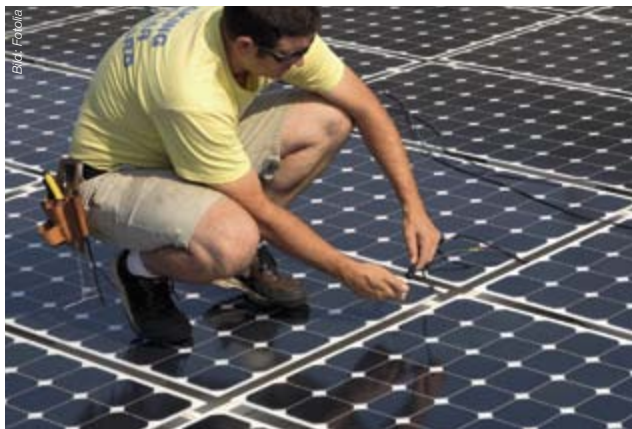
Wachstumsbranche Sonnenenergie: Montage einer Fotovoltaikanlage.
