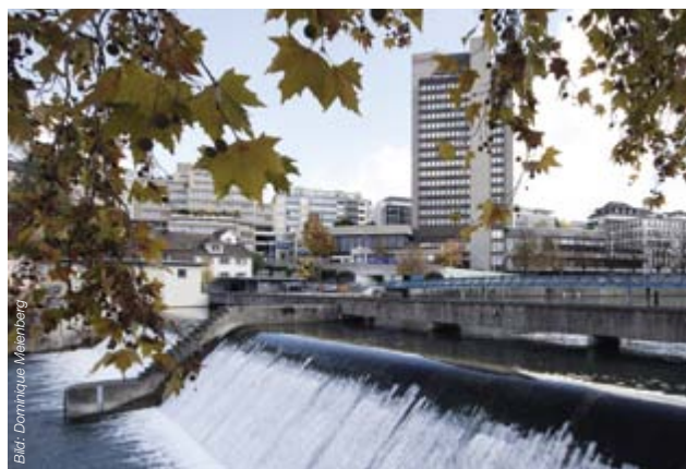
Produziert mitten in der Stadt Ökostrom aus Seewasser: Das Kraftwerk Letten.
